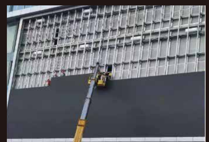
壁面固定用デジタルサイネージ工事過程
